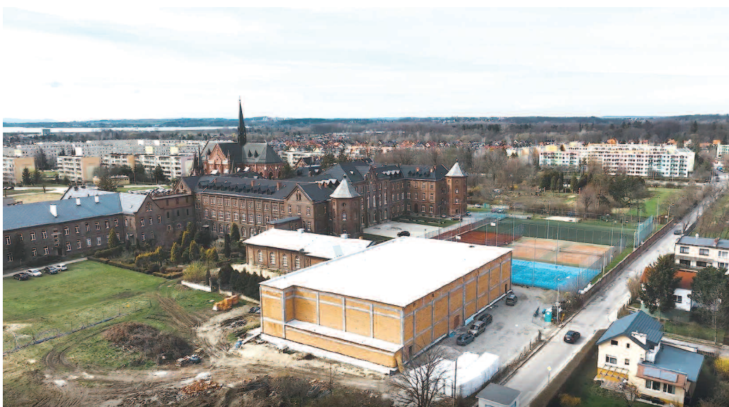
Budowa pełnowymiarowej sali gimnastycznej w Zespole Szkół i Placówek Oświatowych w Nysie
