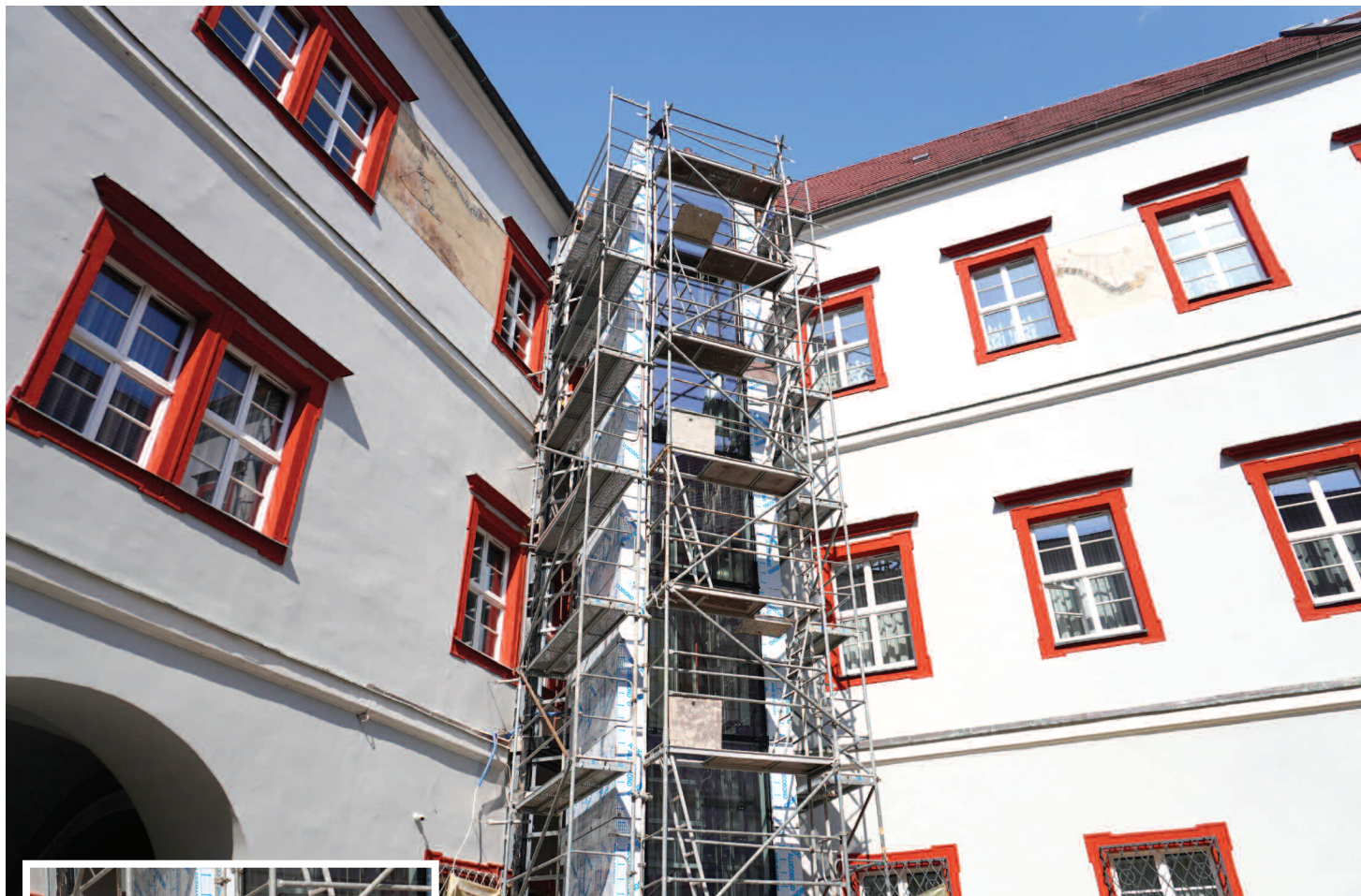
Budowa windy w Muzeum Powiatowym w Nysie
