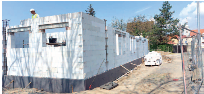
Postęp pracy przy budowie placówki w Korfantowie - maj przeprowadzkę młodych lokatorów.
