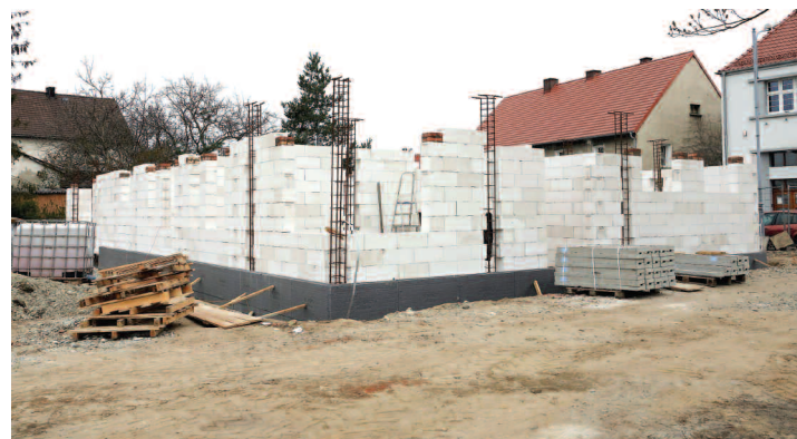
Postęp pracy przy budowie placówki w Korfantowie - kwiecień
