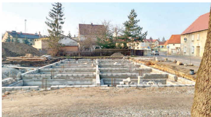
Postęp pracy przy budowie placówki w Korfantowie - marzec
